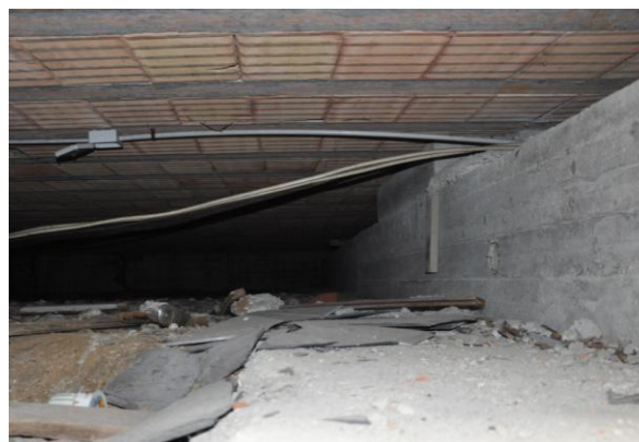
Figura 4.2 - Particolare del solaio della palestra
