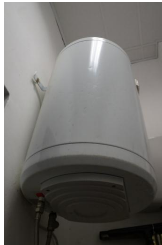
Figura 4.14 - Particolare della caldaia murale per produzione di ACS in cucina
