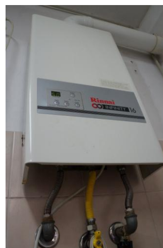
Figura 4.14 - Particolare della caldaia murale per produzione di ACS in cucina
