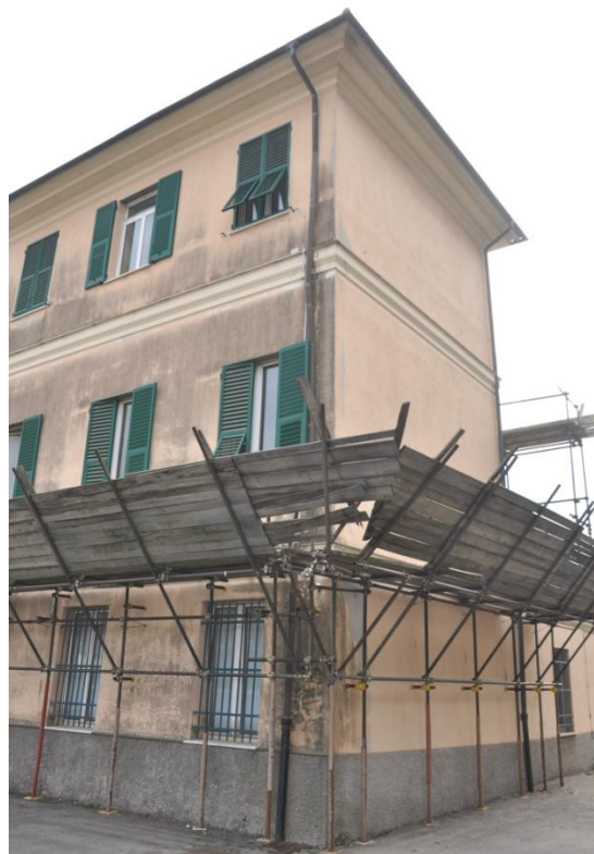
Figura 1.1 - Vista delle facciate nord-nord/est
