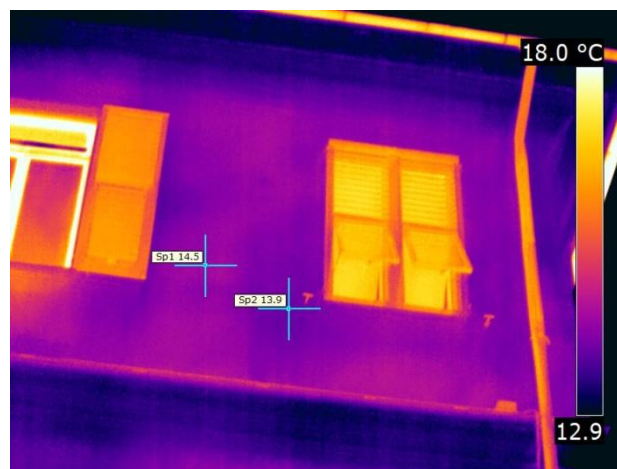
Figura 8.3 – Particolare termografia parete esterna
