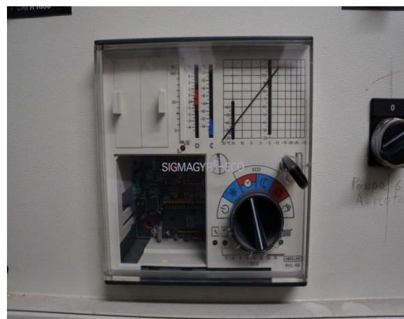
Figura 4.8 - Centralina di controllo in CT
